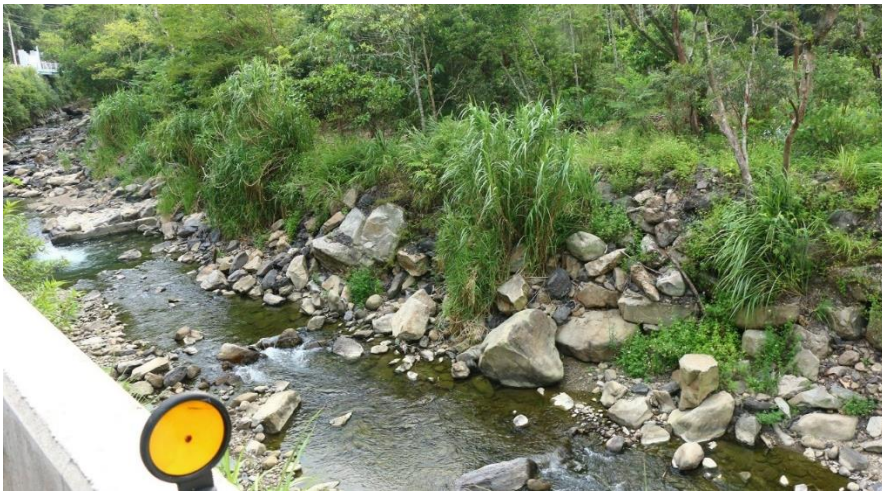
照片 6-4 平廣溪溪床的大量土石埋積（民國 105 年 4 月 1 日攝）
