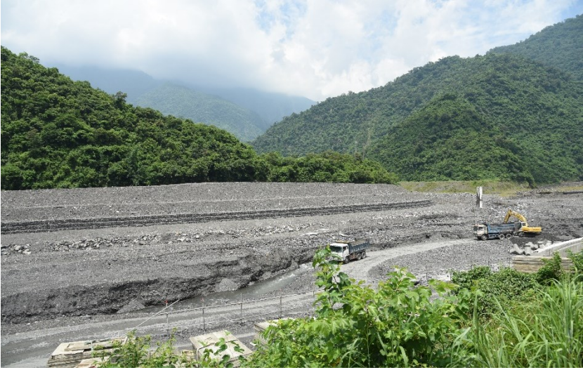
圖 4-2 河道清淤後就近堆置的土砂（土砂堆置區）。其外觀與天然的低位河階或小階地形差異，主要在於非常平整、無明顯河流作用形成的堆積層理（2022.07）
