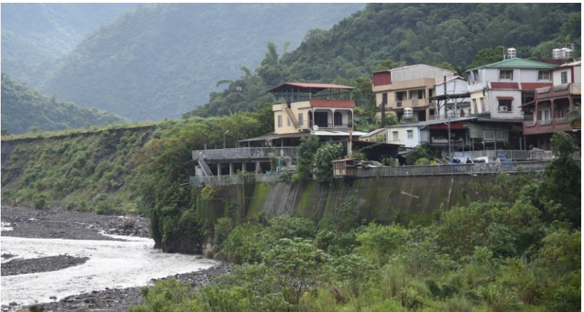
圖 2-7 來義土石流扇階末端的河蝕崖。該河蝕崖目前已部分興建護岸，以保護不受河水側蝕。照片左側頂部平坦的階地，為來社溪河道疏濬後的土砂堆置區 (2021.08)
