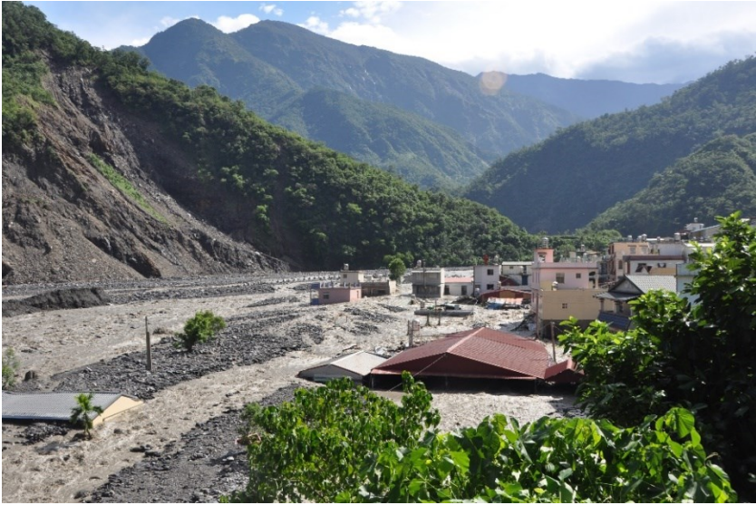
圖 4-12 凡那比颱風過境後洪水侵襲東部落。由於前 1 年莫拉克颱風造成大量土砂淤埋於來社溪河床，使凡那比颱風豪雨造成的洪水侵襲東部落較低的位置（2010.09）
