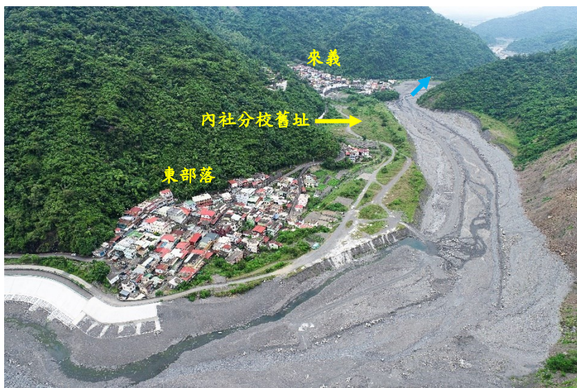
圖 4-1 來社溪來義至東部落河段河床上的大量土砂 (2022.08)
