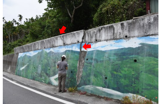
照片 3-3 點 7 擋土牆局部開裂且有向外側傾倒趨勢 (攝於 2020 年 9 月 9 日)
