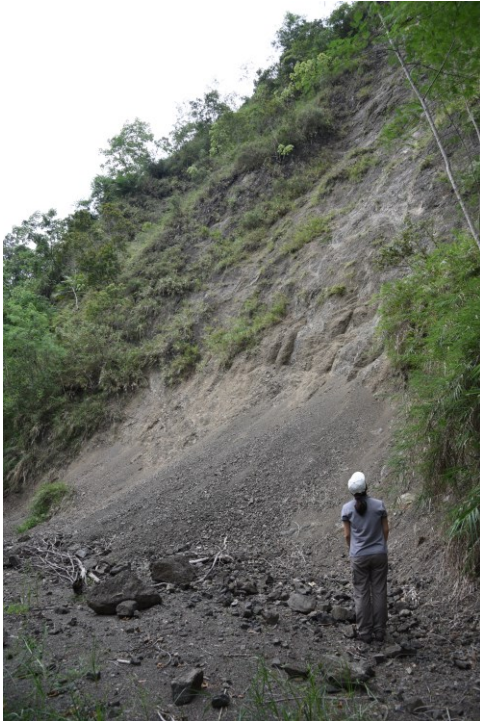
照片 4-1 吉祥溫泉民宿東方崖壁的落石。為安山岩質岩塊表面風化後崩落，並於坡腳堆積小規模錐狀落石堆地形（2020 年 9 月 9 日攝）
