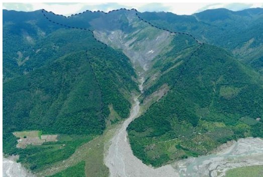
圖 3-2 布唐布那斯溪空照圖，虛線為集水區範圍，可見歷次岩體滑動之大範圍滑動面裸露地（2023 年 7 月 24 日攝）
