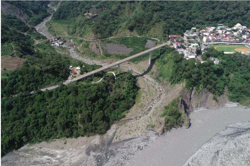
圖 5-1 桃源一橋舊路及新橋（2018 年 9 月 18 日攝）
