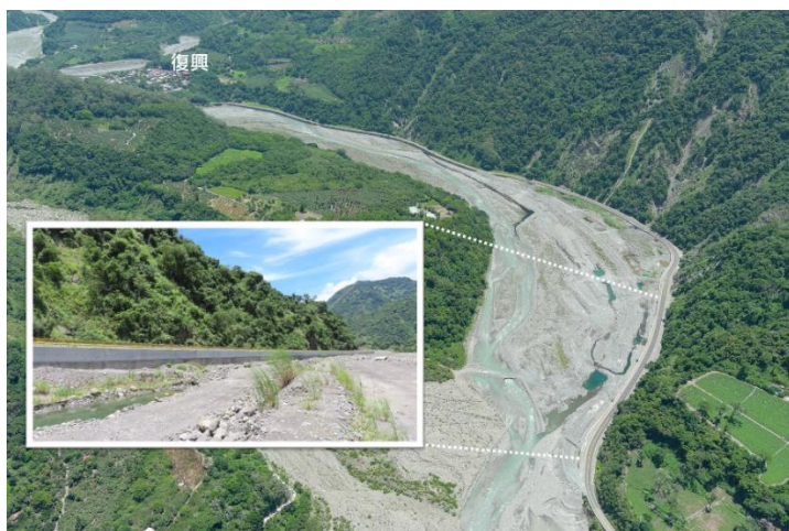
圖 5-3 台 20 線 96.5K 至 98.5K，部分路段可見路基加高痕跡 (2023 年 7 月 24 日攝)
