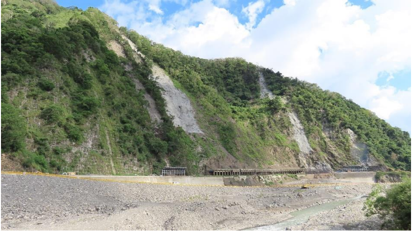
圖 3-8 台 20 線南橫公路 100.5K 為岩屑崩滑及落石好發路段，邊坡以噴漿方式加固，並設有明隧道，於 2023 年 6 月 26 起進行明隧道加長工程，預定 2024 年 3 月完工（2023 年 7 月 24 日攝）
