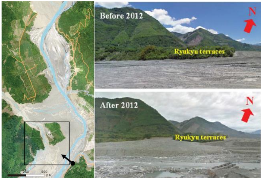
圖 3-15 2012 年布唐布那斯溪土石流作用於琉球臺扇階面
