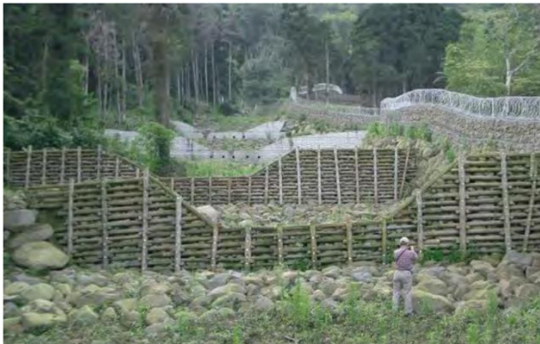
圖 2-10 三號坑設置之竹樁壩
