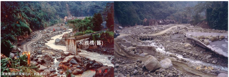
圖 5-16 北勢溪和雅橋河段於颱風事件中的受災情形
