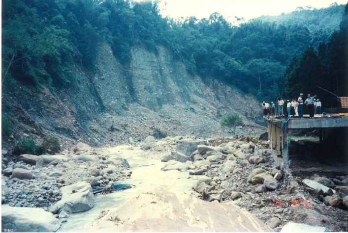
圖 3-4 賀伯颱風造成內樹皮河蝕崖面岩屑崩滑 (民國 85 年 8 月 19 日攝)
