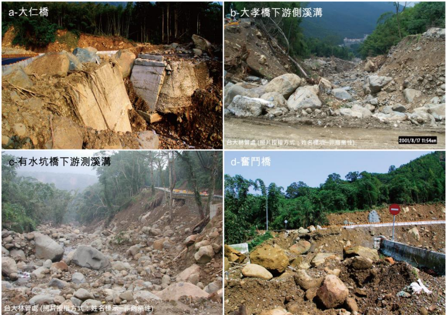
圖 5-3 民國 90 年桃芝颱風造成多條野溪土石流，甚至導致橋梁損毀。
