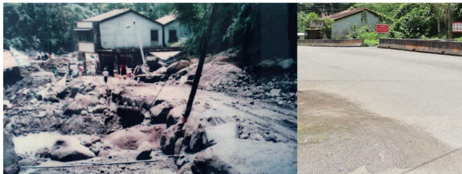
圖 5-9 民國 90 年桃芝颱風期間溪坪橋再度受土石流衝擊，民國 92 年溪坪橋完成重建，路基加高一層樓 ( 約 3 公尺 ) 高，藉此提高用路安全。
