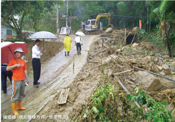
圖 3-18 莫拉克颱風造成龍水溪仔發生土石流，土石堵塞溪溝。 (民國 98 年 8 月 11 日拍攝)
