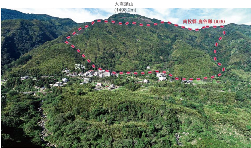
圖 4-10 南投縣-鹿谷鄉-D030 大規模崩塌潛勢區空拍照片 (民國 113 年 5 月 15 日拍攝)
