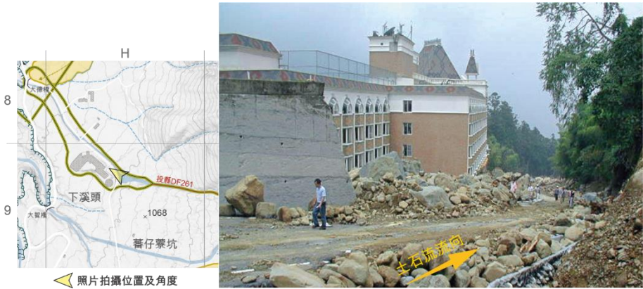
圖 5-6 民國 90 年桃芝颱風土石流侵襲米堤飯店
