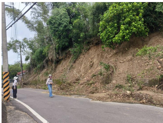
圖 3-13 凱米颱風導致南 165 鄉道發生小規模岩屑崩滑
