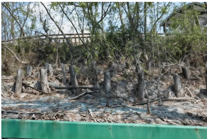
圖 4-11 打樁編柵工法
