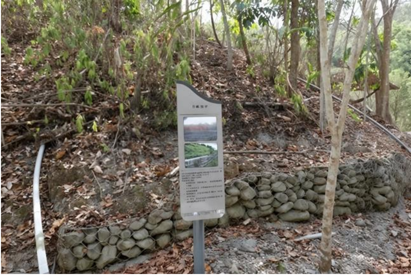
圖 4-14 石籠護坡工法
