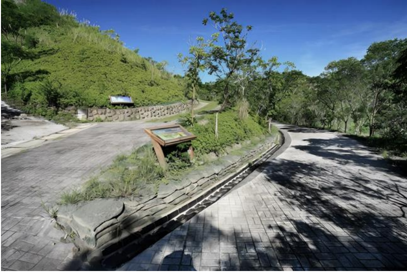
圖 4-15 瓦片溝工法
