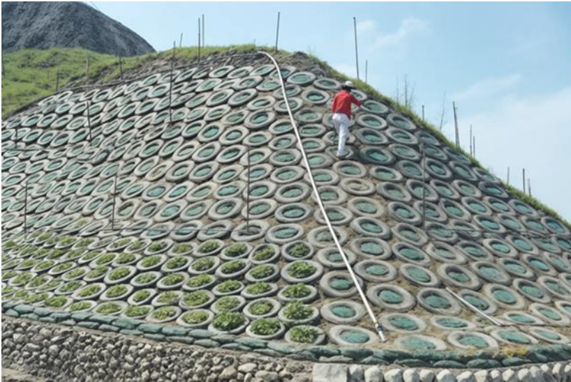
圖 4-13 輪胎邊坡工法
