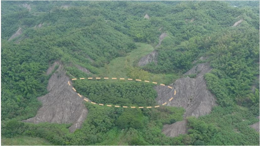
圖 3-4 牛埔農塘西南側之土壩結構現況
