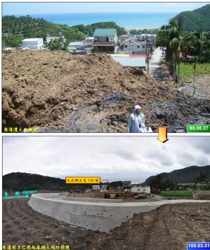
圖 4-4 民國 98 年莫拉克颱風大烏部落道路遭土石掩埋，聚落通行受阻（上圖）；災後設置混凝土堤防引導土石流流入北一溝，保護部落道路（下圖）。
