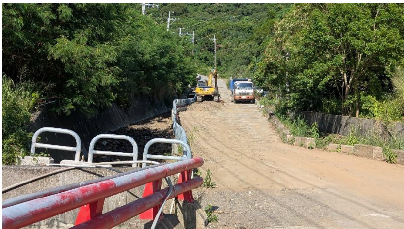
圖 3-6 排水溝疏浚與拓寬工程。
