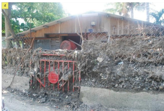
圖 5-4 土石流在北溝匯入鳥萬溪處造成大量土石淤積而淹入民宅 圖片來源：莫拉克新聞網；照片提供者：楊念湘（民國 98 年 10 月 18 日攝）
